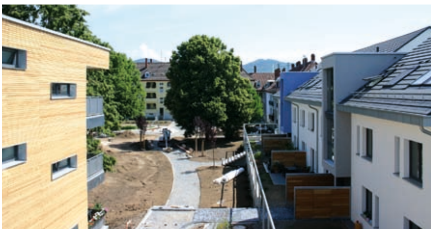
Das neue Quartier im Mai
