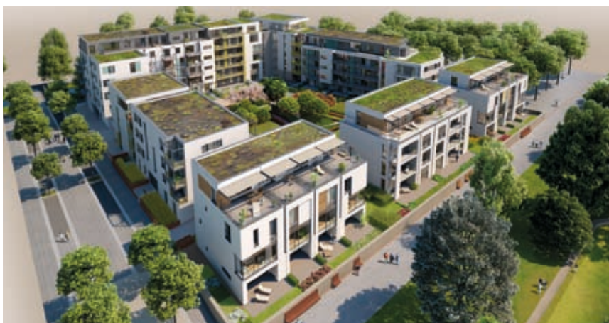
Erste Wohnbebauung in der Bahnstadt: Schwetzinger Terrassen der GGH
