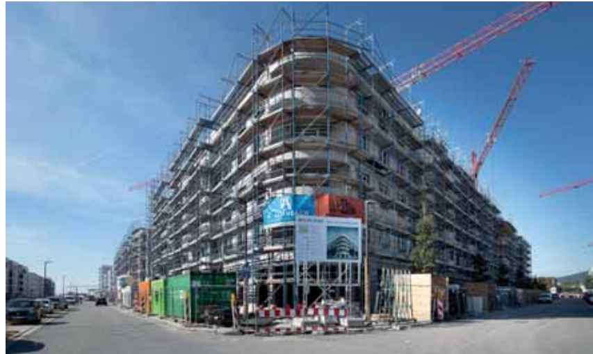
Das MEILEN.STEIN-Quartier in der Bauphase Spätsommer 2018
