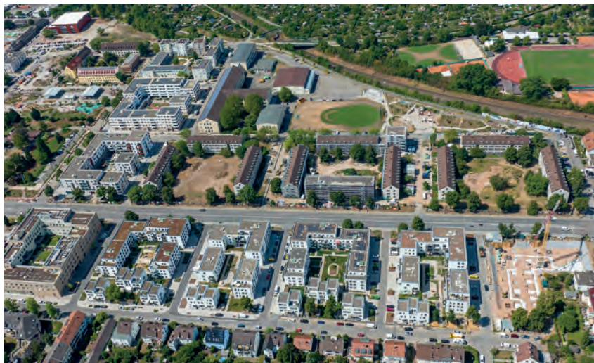
Das Mark-Twain-Village in der Südstadt. Insgesamt entstehen auf dem Areal rund 1.200 Wohneinheiten. (Foto MTV/Henrich)
